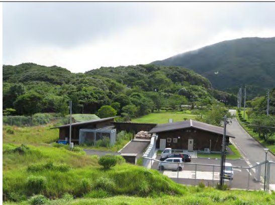
一時収容棟(左)及び調査研究棟(右)
