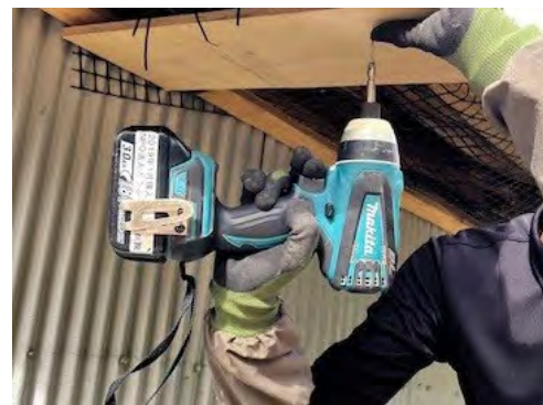
小屋の修繕の様子
