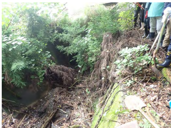
閉鎖したカルバート（小鹿）
