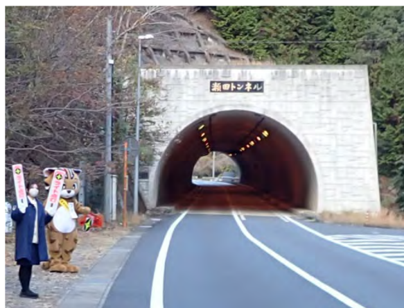
トンネル内ライト点灯推進活動の実施の様子
